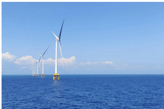
广东惠州海上风电场安装工程
