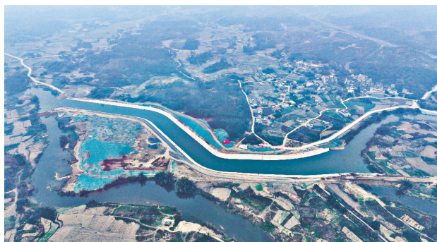
广西平陆运河重大工程进展顺利
