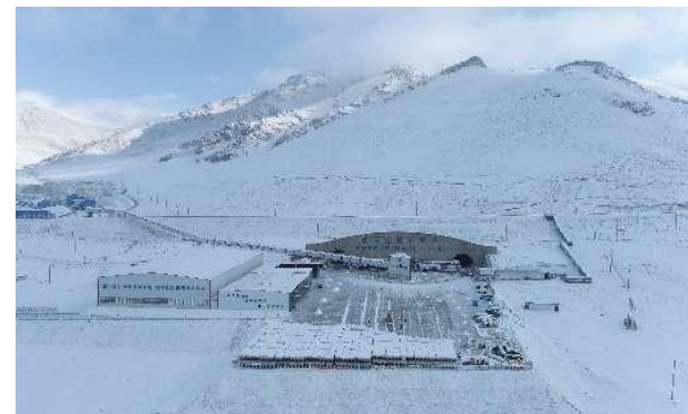
新疆乌尉高速公路天山胜利隧道全线贯通
