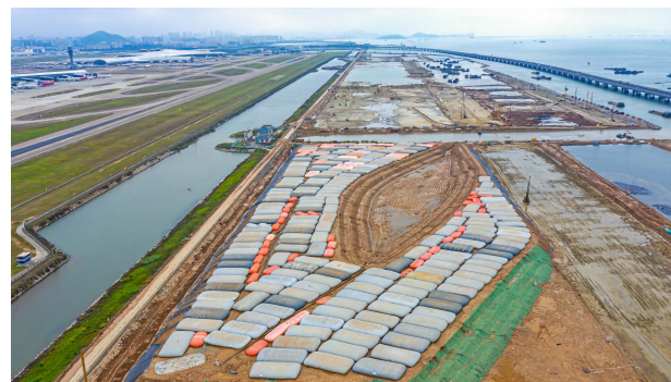
深圳机场三跑道扩建工程竣工验收
