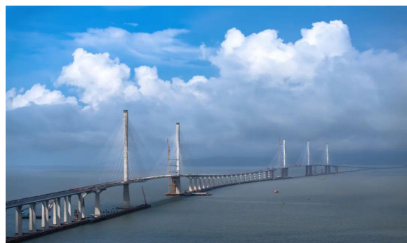
广东黄茅海跨海通道黄茅海大桥
